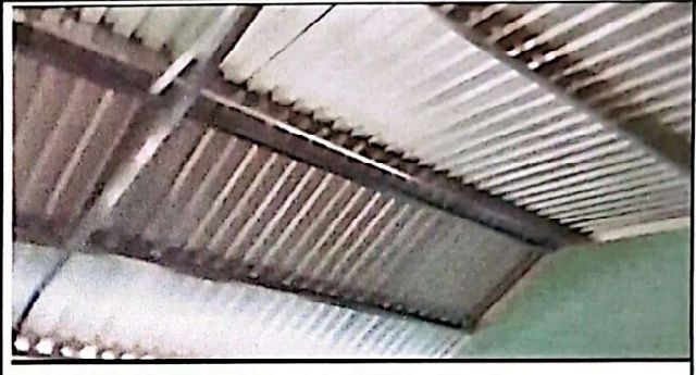
Foto 2: CAMBIO TOTAL DE LAS COSTANERAS DE LAS AULAS
