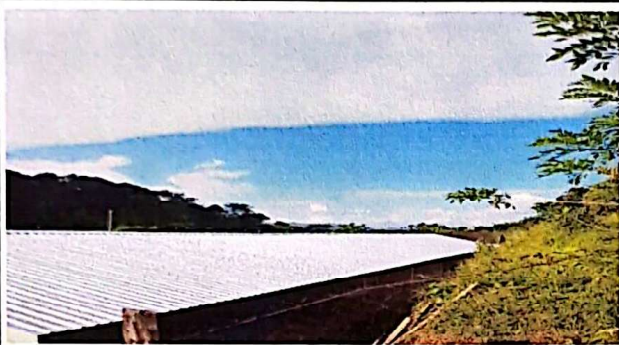
Foto 1: LAMINAS TOTALMENTE CAMBIADAS
